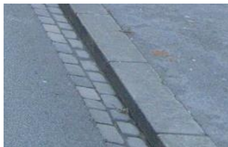
Figur 6-4: Prinsipp for gjennomgående kant på strekningen.
