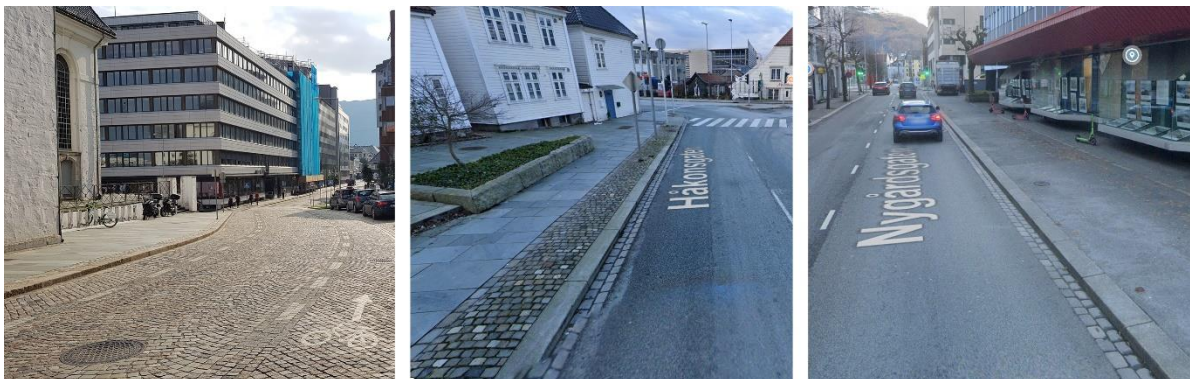
Figur 6-2: Eksempler på ulike gateromsstandard. Fra venstre: Natursteinsdekker i hele gateprofilen (Strandgaten). Midten: Asfaltert kjørebane og natursteinsdekke på fortaut (Håkonsgaten). Til høyre: Asfaltert kjørebane skilt fra asfaltert fortaut med granittkant og rennestein (Nygårdsgaten). (Foto: Til venstre: NOAV, midten og høyre: Google Street View.)
